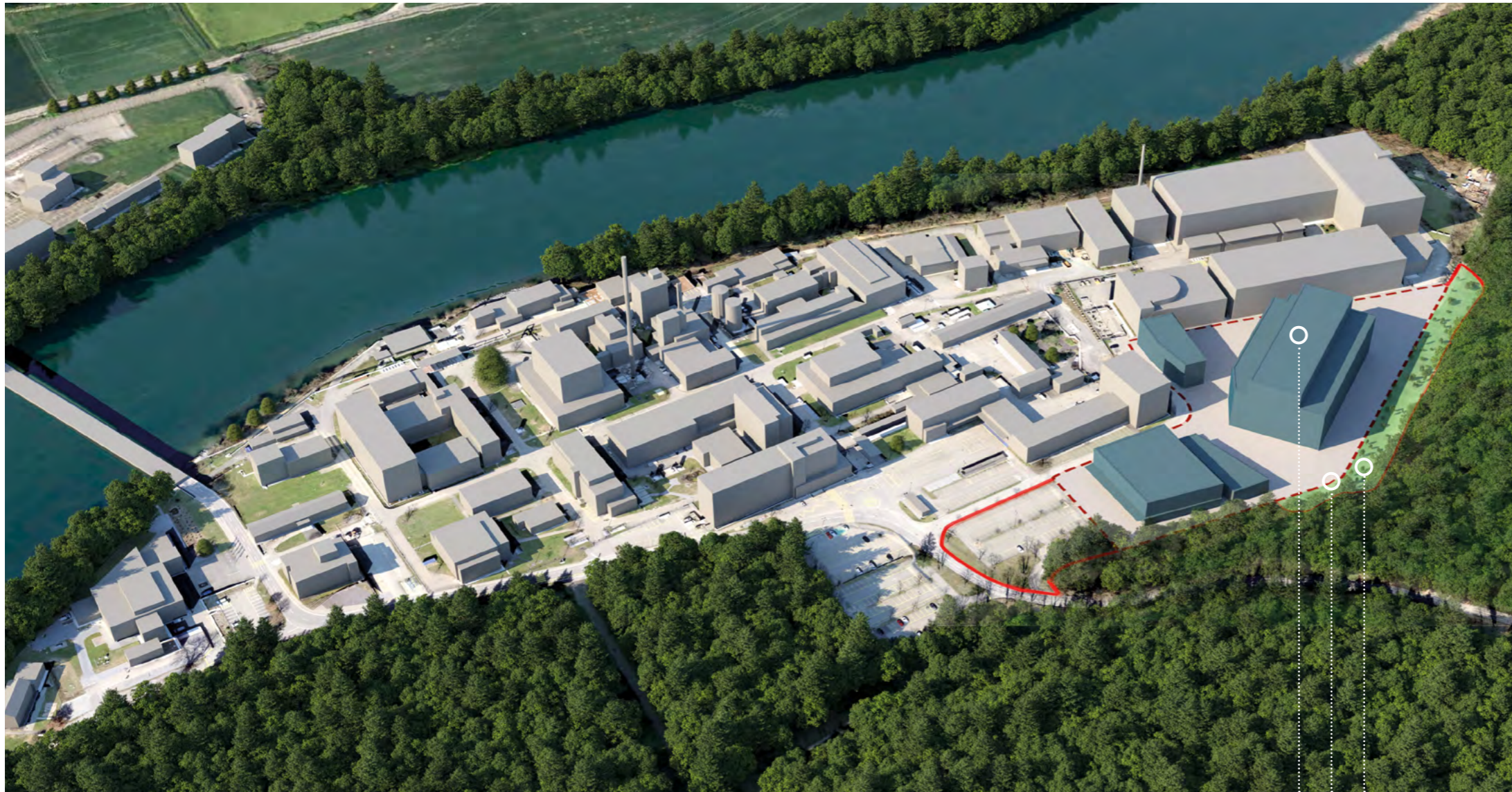
L'installation de conditionnement pour éléments combustibles usés sera construite sur le site du Zwilag
